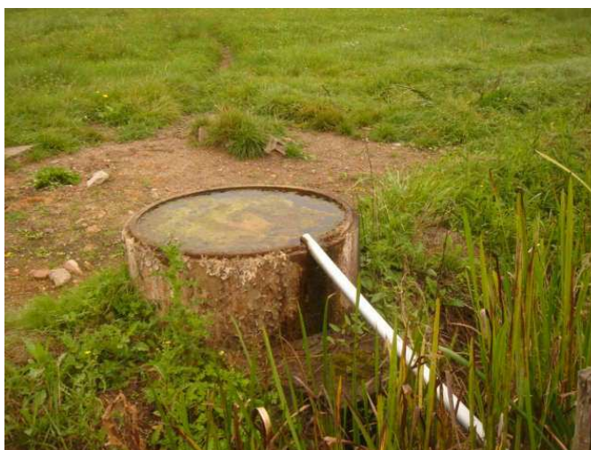
Figure 55 : Captage d'une mouillère pour l'abreuvement avec maintien de la zone humide grâce au trop plein
