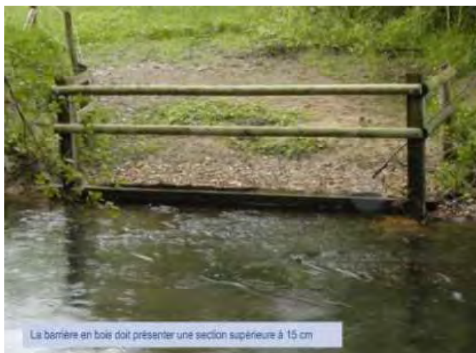
Figure 56 : dispositif permettant l'abreuvement des animaux sans descente dans le lit du cours d'eau
